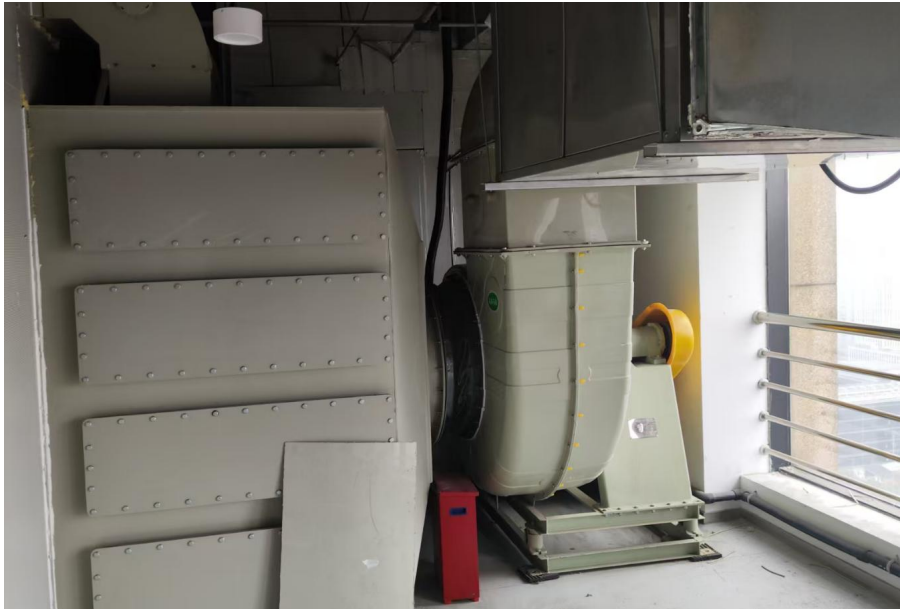
24 层废气处理装置照片
