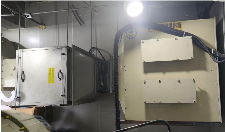
24 层废气处理装置照片
