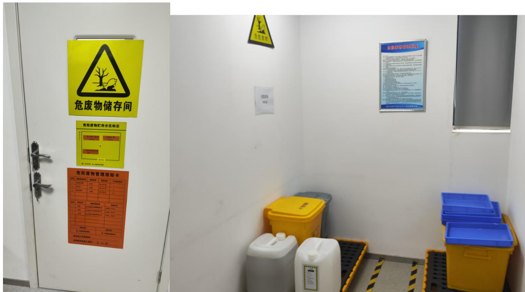
25层危废暂存间
