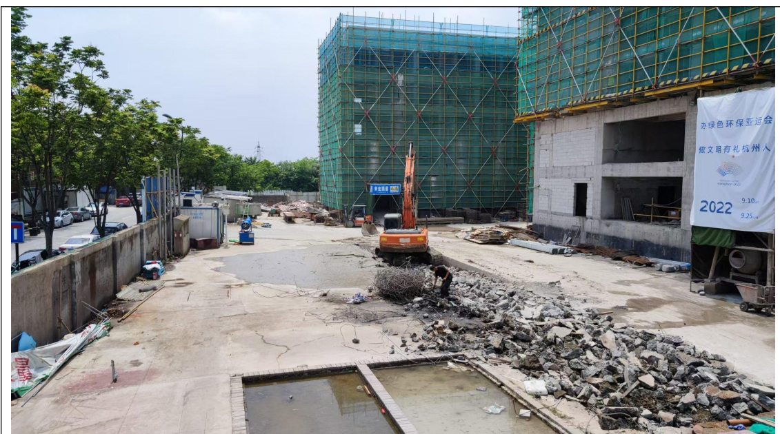
图 3-1 施工场地路面硬化及喷雾设施
