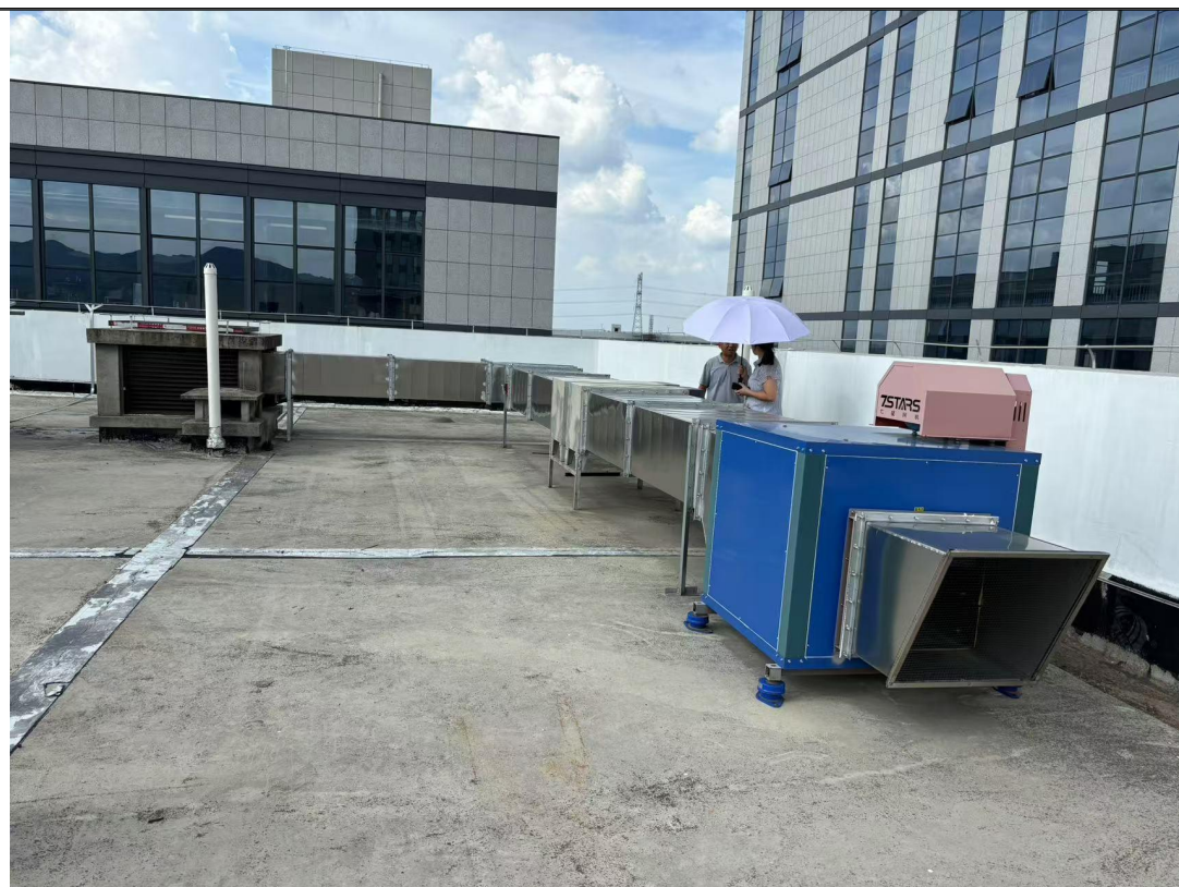
图 3-1 油烟集气罩及净化设施
