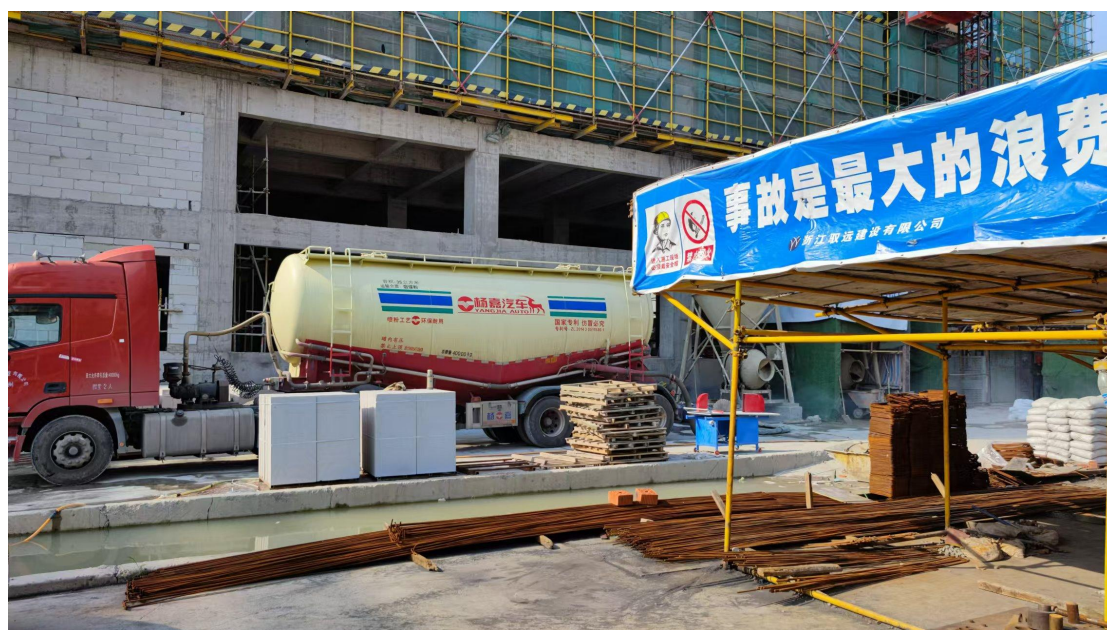
图 3-2 施工场地沉降池、物料堆放场所
