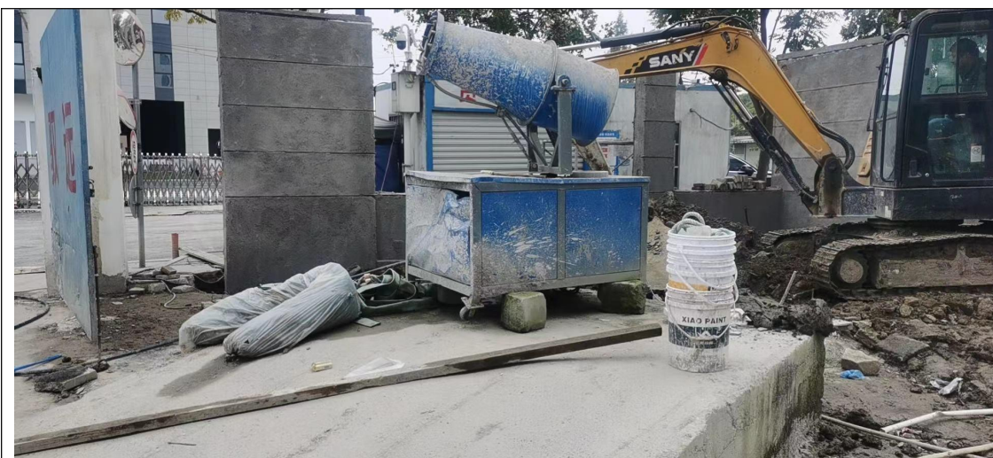
图 3-3 施工场地雾炮机
